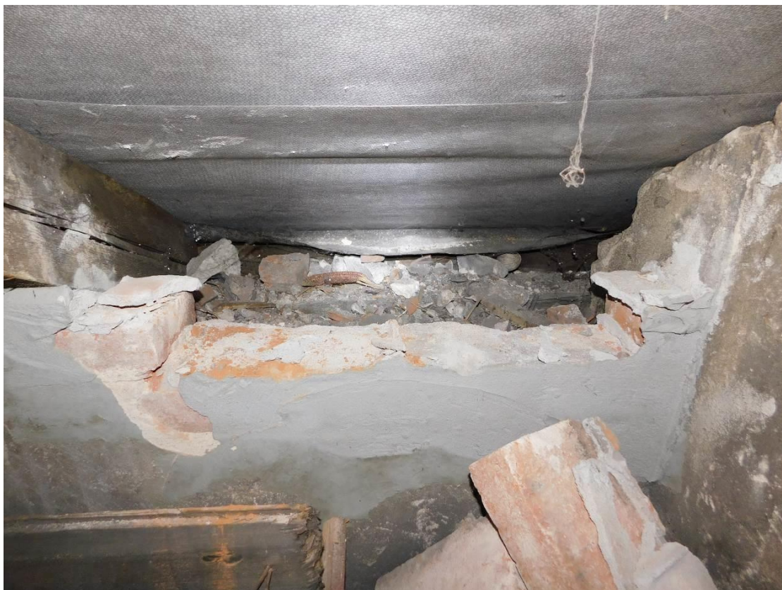
Foto 19 – Brandýs nad Labem - krov - sonda k pozednici - bez viditelných poruch, pozednice zasypána sutí !
