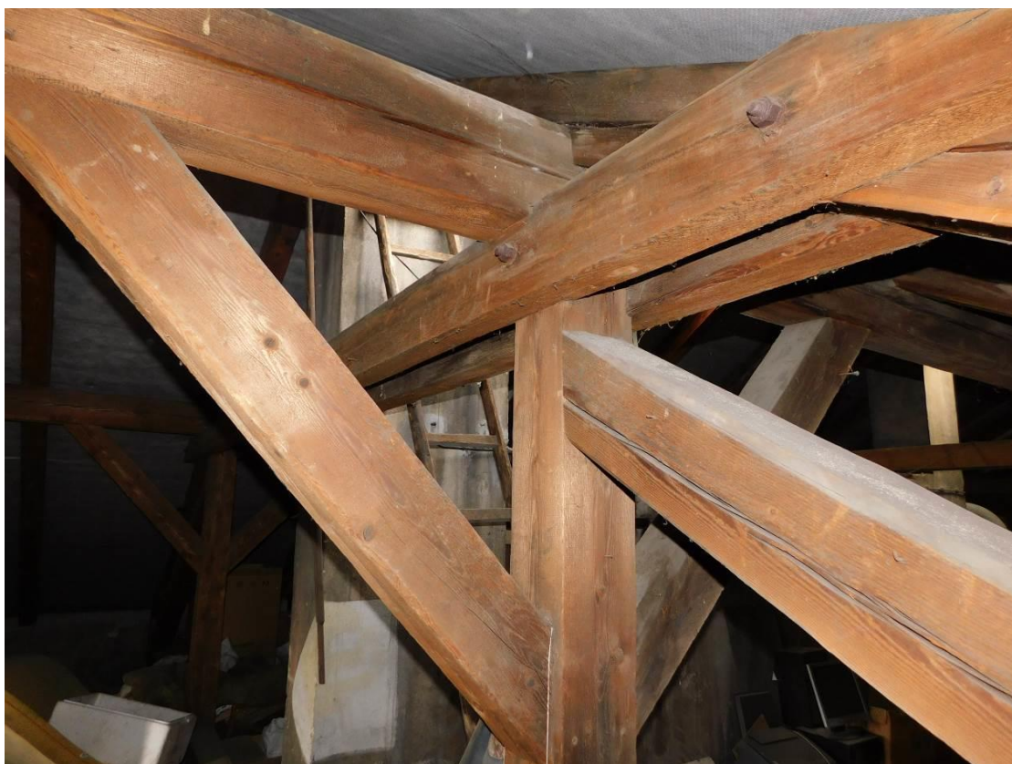
Foto 20 – Brandýs nad Labem - krov – bez viditelných poruch
