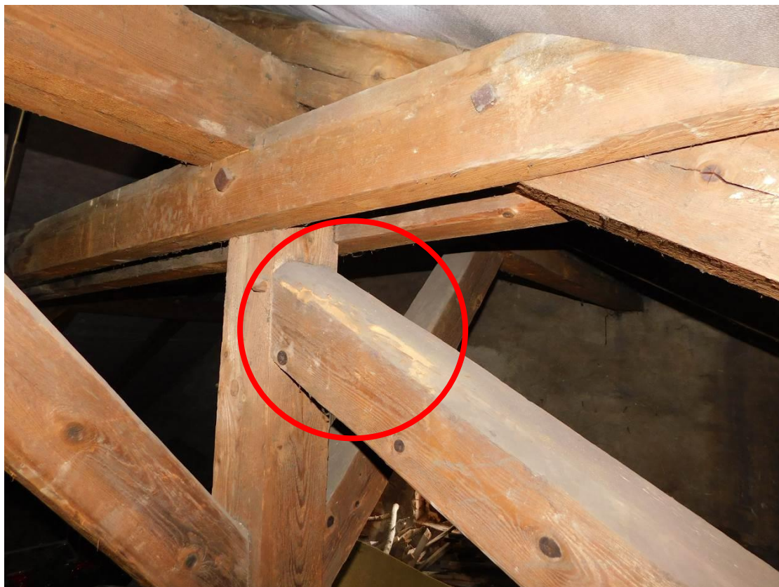
Foto 17 – Brandýs nad Labem – krov - poškození dřeva vzpěry stupeň DH1-2 - červotoč
