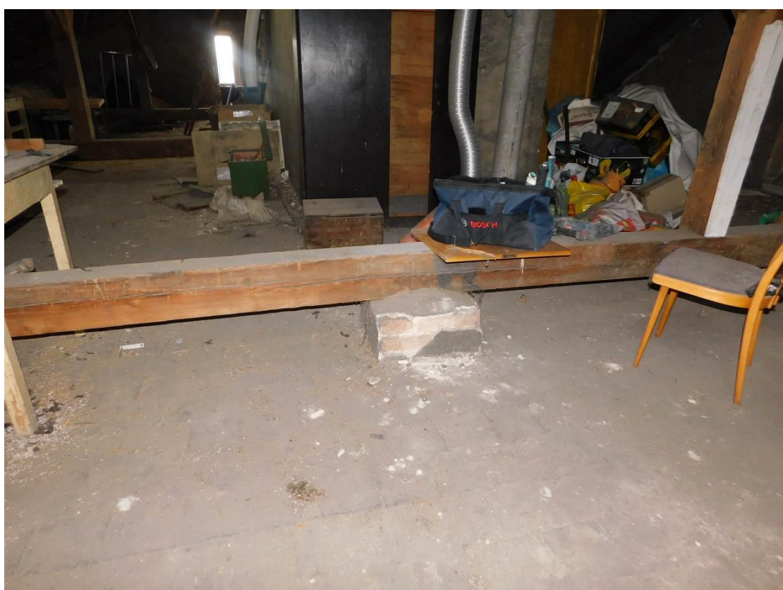
Foto 24 – Brandýs nad Labem – krov – charakter uložení vazného trámu uprostřed rozpětí
