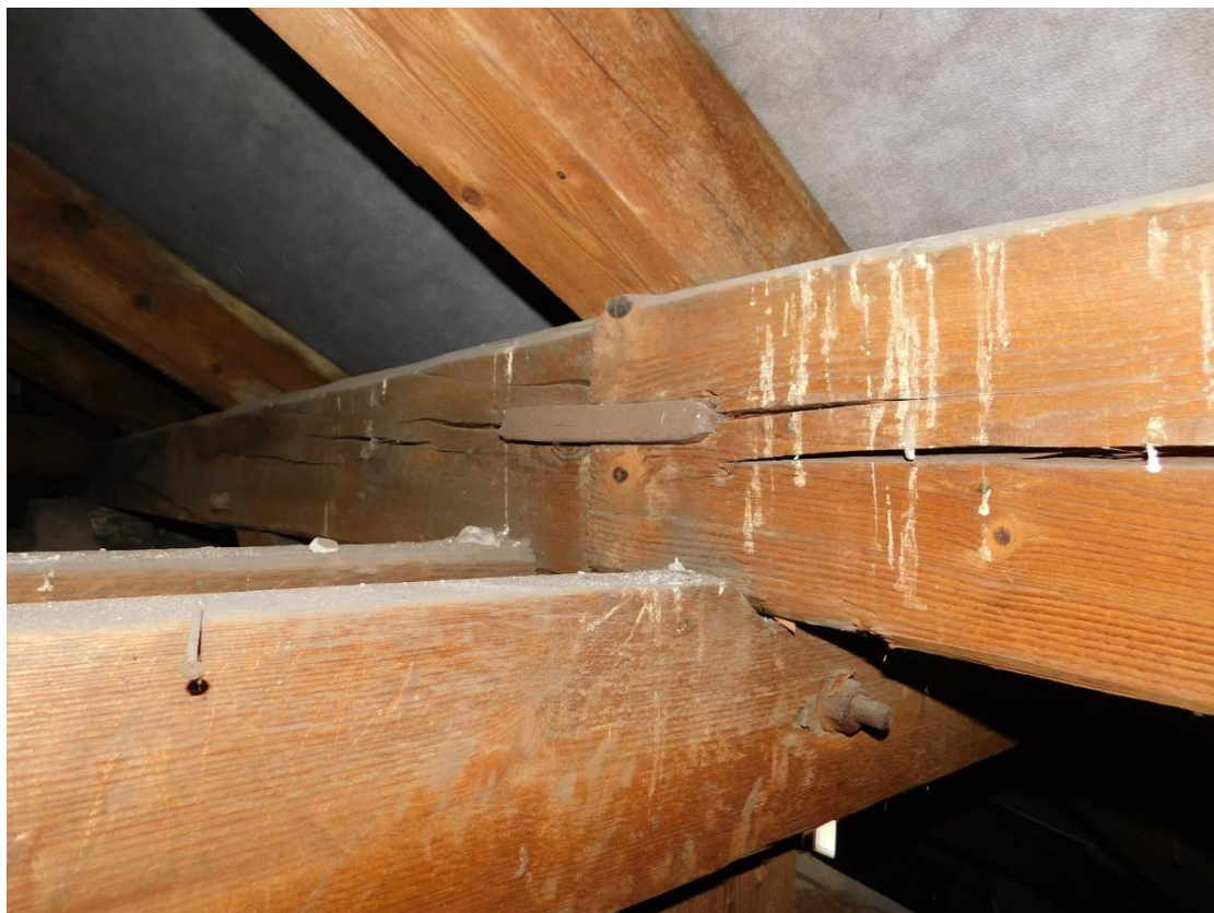
Foto 8 – Brandýs nad Labem – krov – spoj mezilehlé vaznice kramlí
