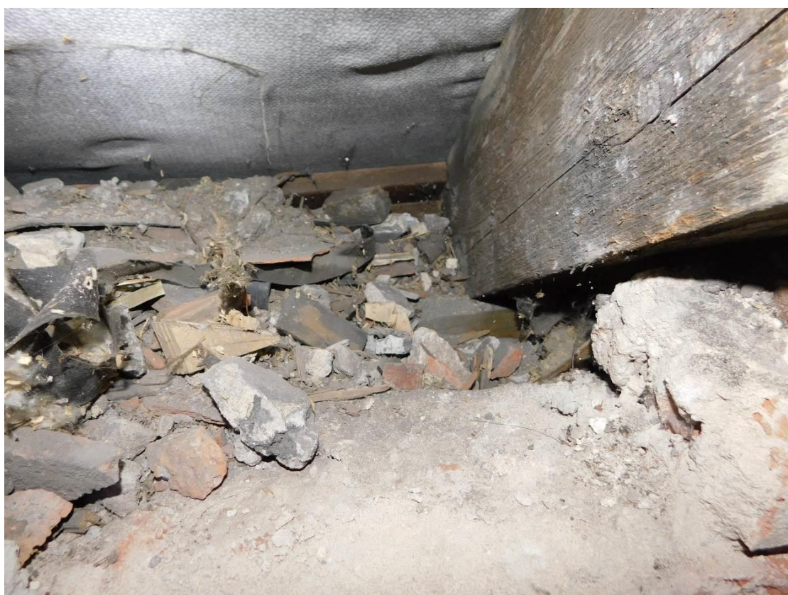
Foto 18 – Brandýs nad Labem – krov - sonda k pozednici - bez viditelných poruch, pozednice zasypána sutí !
