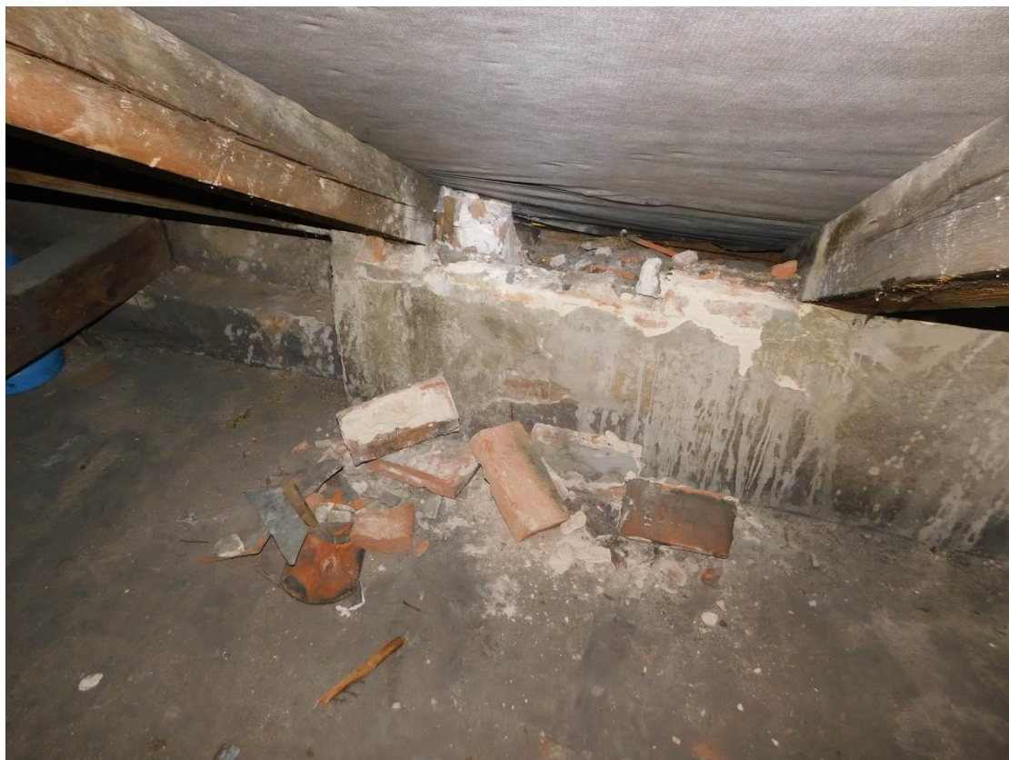
Foto 5 – Brandýs nad Labem - krov – sonda k pozednici – viditelné poškození dřeva stupěň H3, DH3
