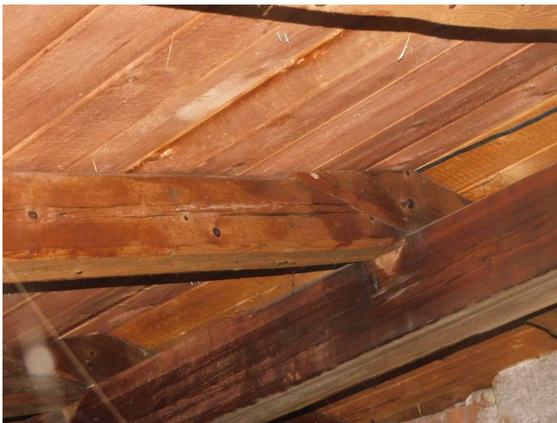
Foto 2.3 – Sledovaná stropní konstrukce, krov – pohled do dutiny, vrcholová vaznice, krokve
