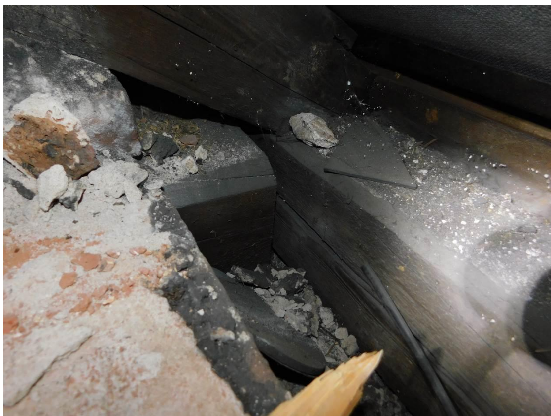
Foto 22 – Brandýs nad Labem – krov - sonda k pozednici - bez viditelných poruch
