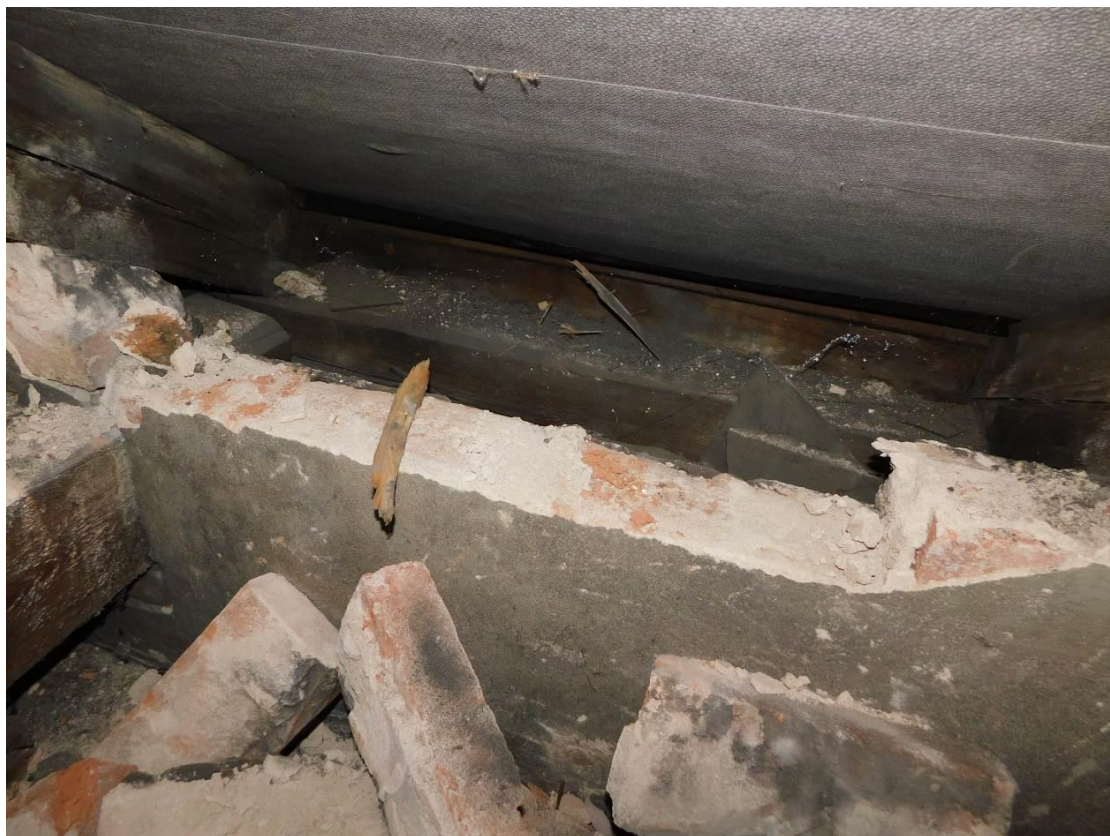
Foto 21 – Brandýs nad Labem – krov - sonda k pozednici - bez viditelných poruch
