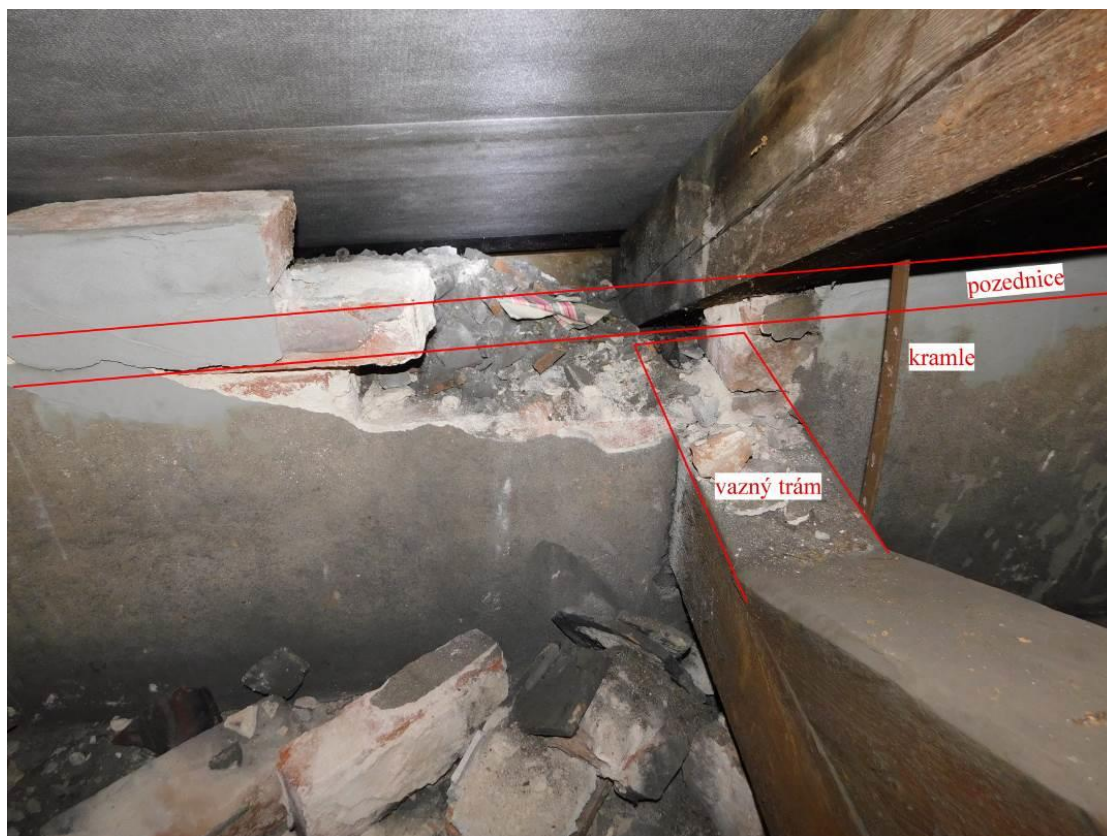
Foto 11 – Brandýs nad Labem – krov – sonda k pozednici - bez viditelných poruch, pozednice zasypána suti !
