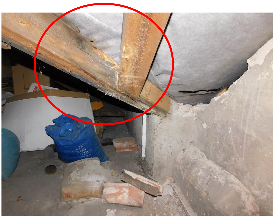
Foto 14 – Brandýs nad Labem - krov – poškození dřeva stupeň DH2, H3
