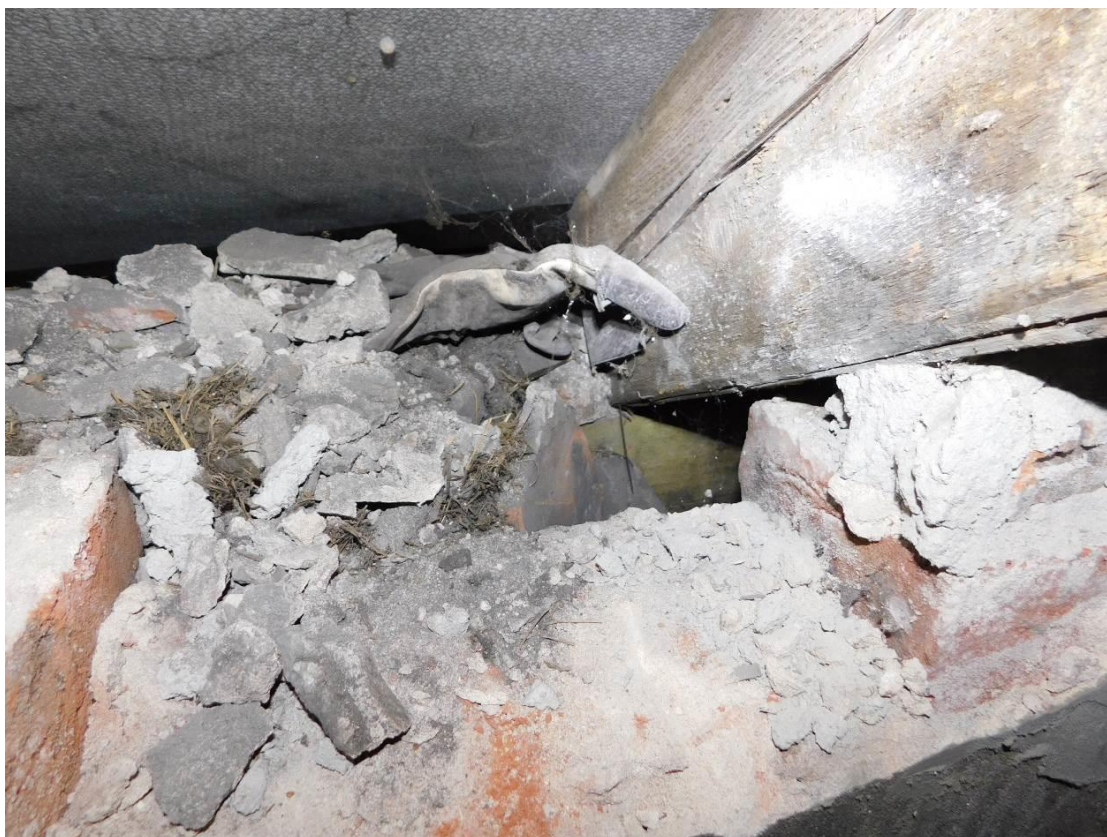
Foto 12 – Brandýs nad Labem – krov - sonda k pozednici - bez viditelných poruch, pozednice zasypána suti !
