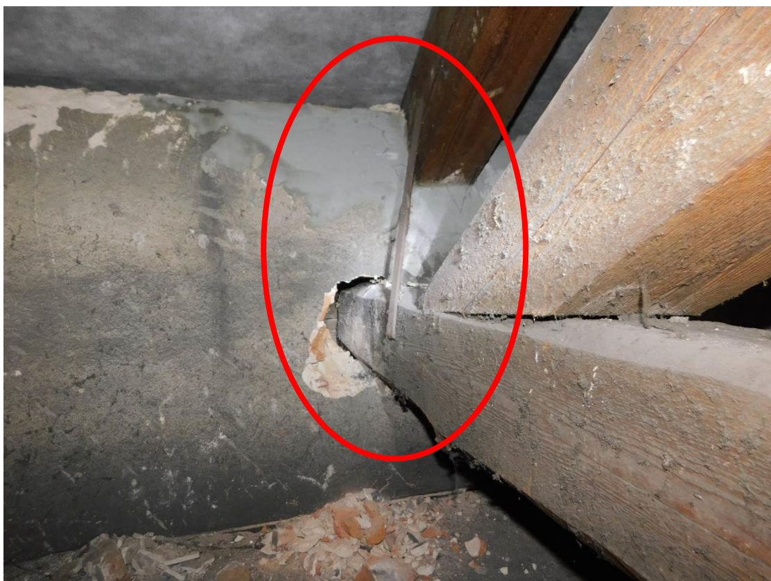
Foto 4 – Brandýs nad Labem - krov – sonda ke zhlaví vazného trámu – bez viditelných poruch, viditelné spojení vazného trámu a krokve kramlí
