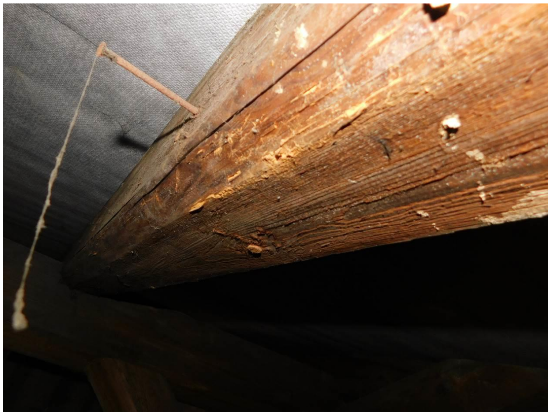
Foto 15 – Brandýs nad Labem - krov – poškození dřeva krokve stupeň DH1 - červotoč
