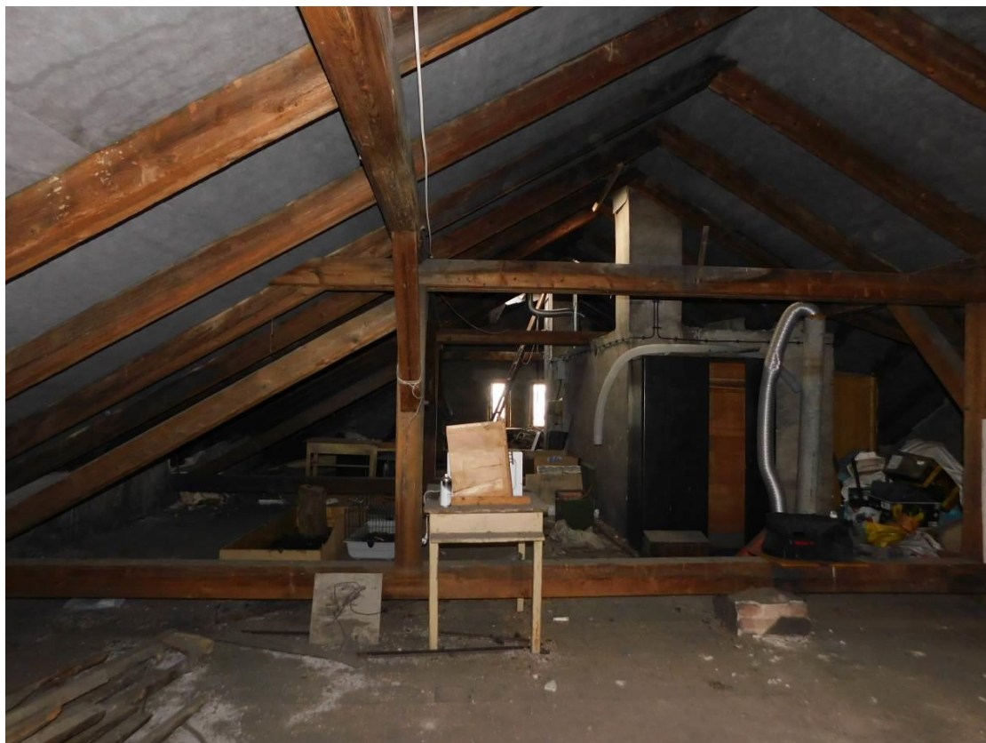
Foto 1 – Brandýs nad Labem - krov – celkový pohled – bez viditelných poruch
