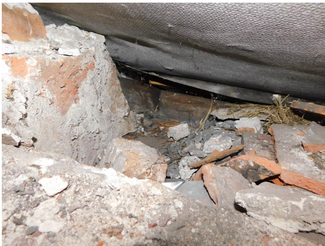
Foto 6 – Brandýs nad Labem – krov - sonda k pozednici – viditelné poškození dřeva stupěň H3, DH3
