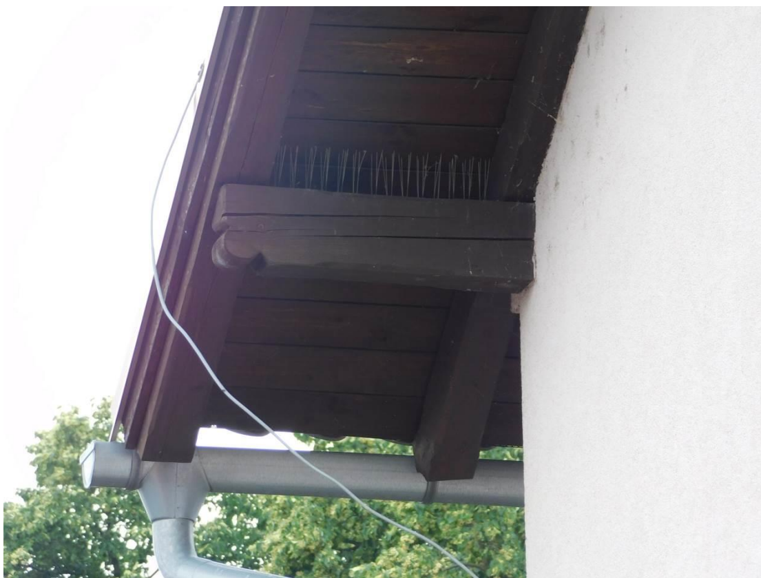
Foto 2.5 – Sledovaná stropní konstrukce, krov – krajní vaznice
