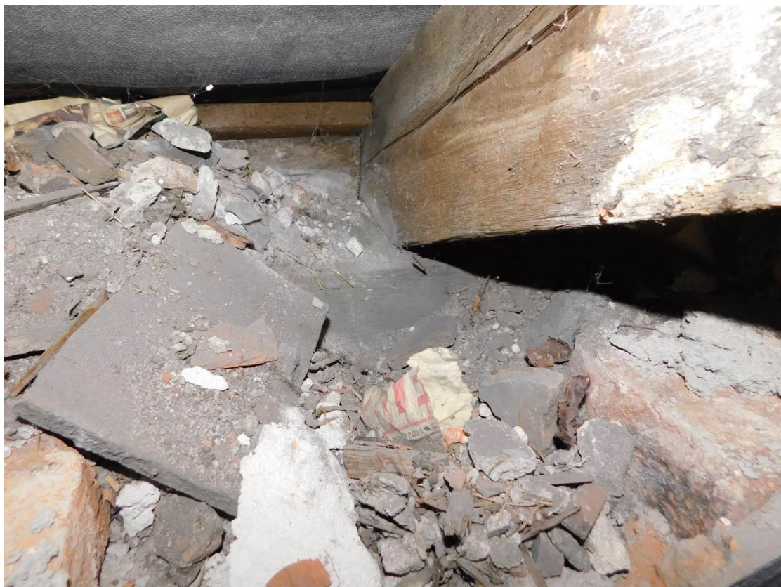
Foto 3 – Brandýs nad Labem - krov - sonda k pozednici - bez viditelných poruch, pozednice zasypána sutí !
