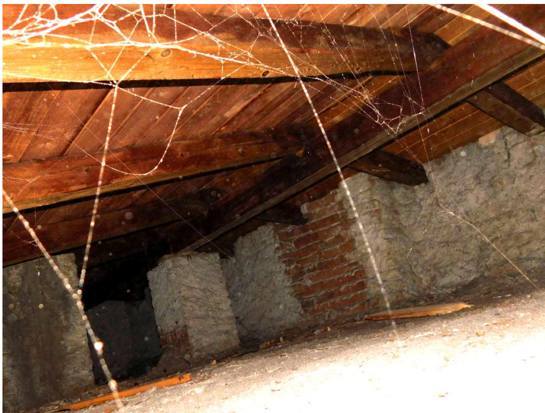
Foto 2.2 – Sledovaná stropní konstrukce, krov – pohled do dutiny, patrný pilířek, který podpírá vrcholovou vaznici viz schématický půdorys v Příloze 3
