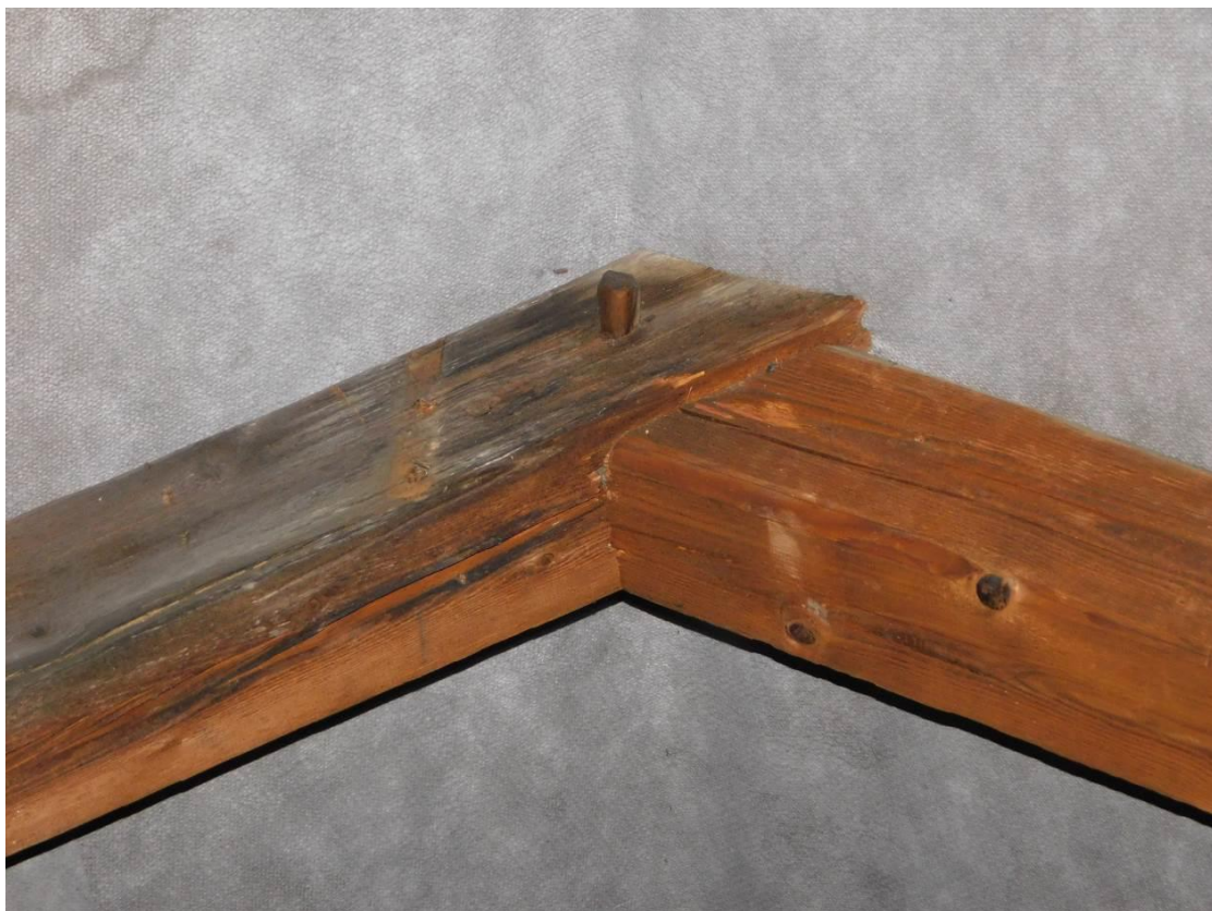
Foto 9 – Brandýs nad Labem – krov – spoj krokví, není vrcholová vaznice
