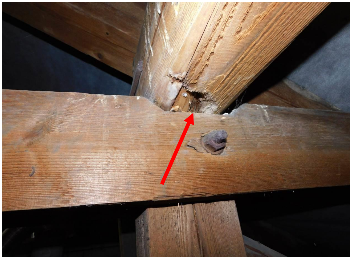
Foto 7 – Brandýs nad Labem – krov – poškození dřeva vaznice stupeň H2
